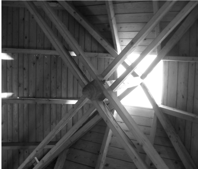
Blick in den Dachstuhl der Mintenbecker Kapelle
